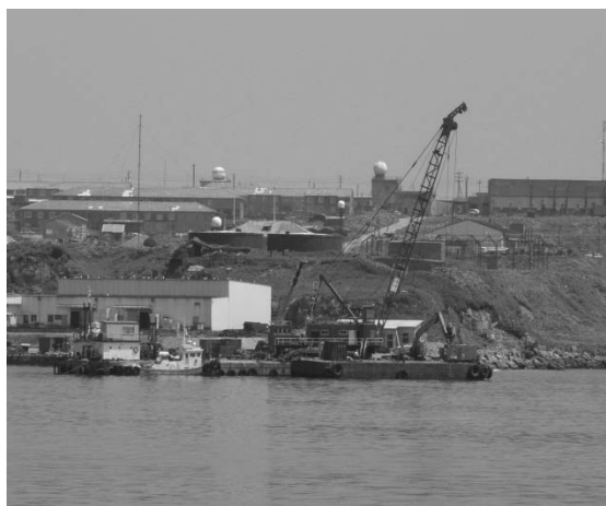
写真1. 古釜布港の港湾整備（2011年）
